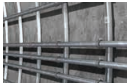
Stabilizacja szyn na ścianie tunelu
