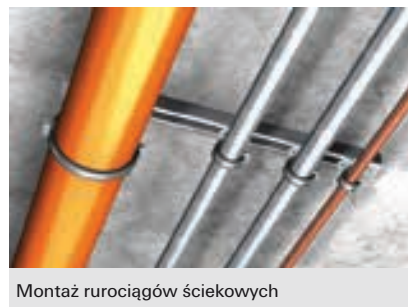
Podwieszona instalacja rurociągu z możliwością regulacji
