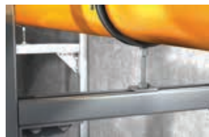
Połączenie z szynami
