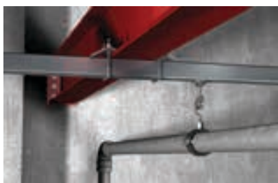
Mocowanie szyny montażowej do dźwigara
