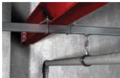
Mocowanie szyny montażowej do dźwigara
