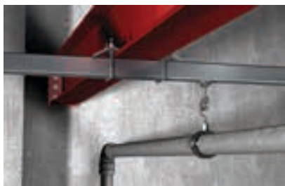
Mocowanie szyny montażowej do dźwigara
