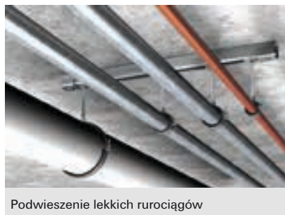
Rurociągi mocowane na wspornikach
