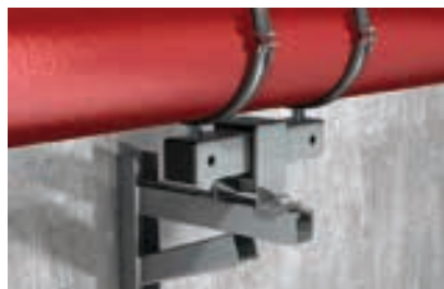
Element ślizgowy na wsporniku
