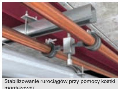
Lekkie instalacje mocowane na wspornikach
