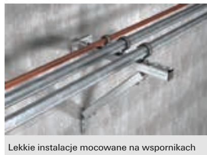
Stabilizowanie rurociągów przy pomocy kostki montażowej
