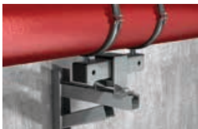
Element przesuwny na wsporniku
