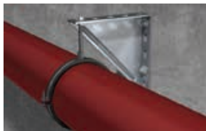
Ciężka rura podwieszona na wsporniku kątowym
