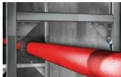
Usztywniona konstrukcja wsporcza
