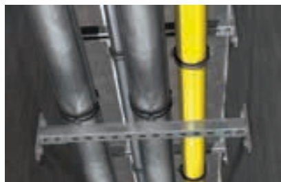
Instalacja rurociągową w drodze ewakuacyjnej
