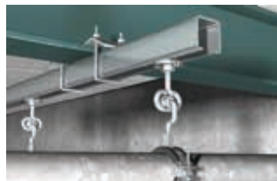
Szyna z podwieszonymi uchwytami ślizgowymi
