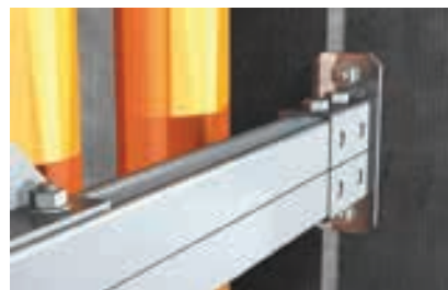
Wspornik ze stopką siodłową
