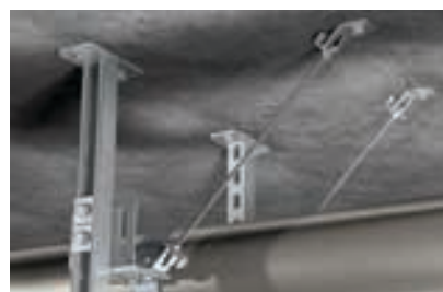
Zamocowanie punktów stałych
