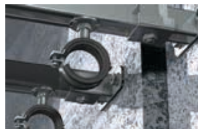
Mocowanie do podłoża
