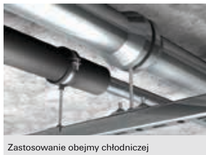
Obejma chłodnicza zamocowana na elemencie przesuwym
