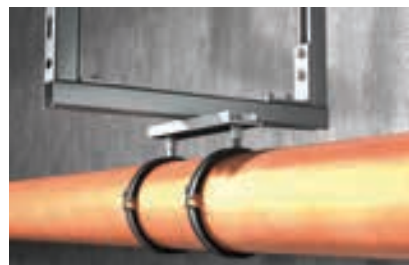
Zastosowanie elementu ślizgowego umożliwia swobodne wydłużanie się rury
