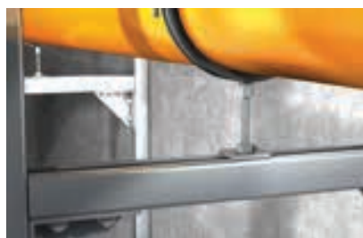
Połączenie z szynami
