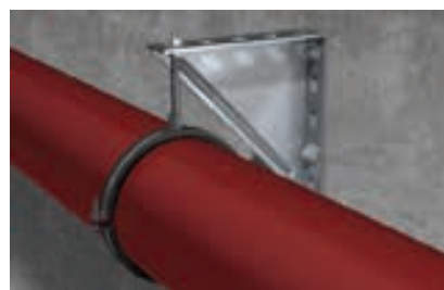
Ciężka rura spustowa zamocowana na wsporniku kątowym
