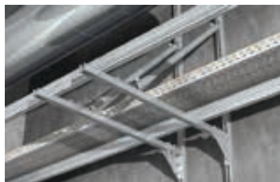
Wsporniki z usztywnieniami
