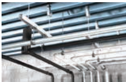
Rurociągi podwieszone do blachy trapezowej
