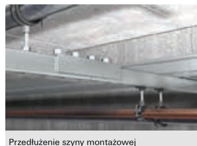
Przedłużenie szyny montażowej
